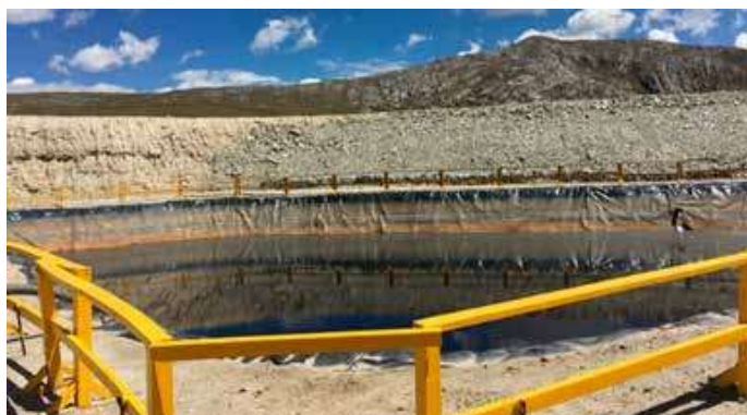
Figura 15. Poza de lixiviados
