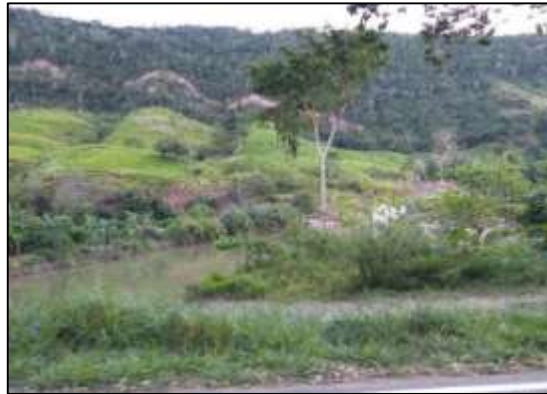
Figura 5A: Deslizamiento en la zona conocida como Bocatoma, esto demuestra la gran inestabilidad de los suelos en las riberas del río Ponaza. (E=371,517.0687 m, Y=9,225,359.3249 m) Fecha de captura: 01/07/2019
