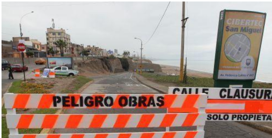
Autorizaciones de Construcción en Zonas de Malecón
